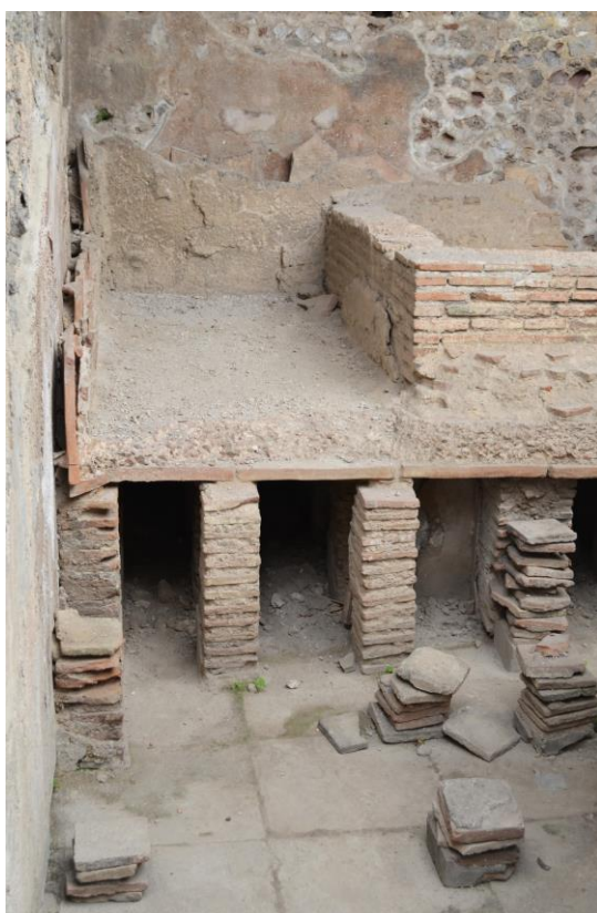
Pompeji. Termerna värmdes upp genom ett välutvecklat system för tillförsel av het luft under golvet och bakom väggarna, s.k. hypokaust.
